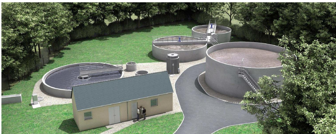
Station d'épuration de Mazé
