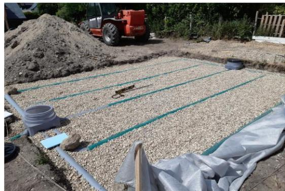
Photo 1 : Filtre à sable vertical non drainé
