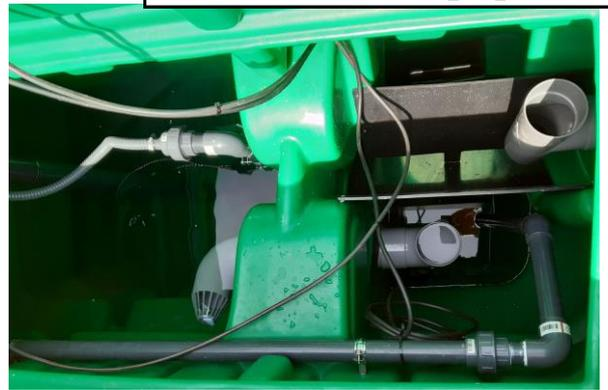
Photo 2 : Intérieur d'une microstation
