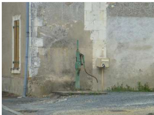
Pompe à eau – Fontaine-Guérin
