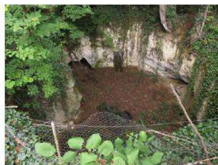
Photo 2 : Effondrement donnant sur plusieurs galeries au lieu-dit Les Sales (Ind. 024)
