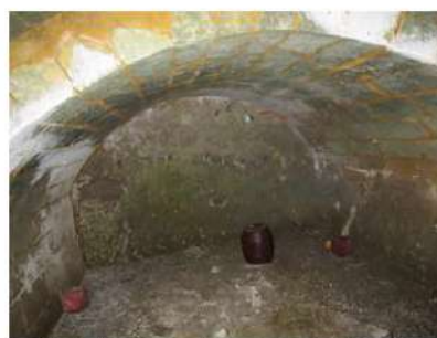
Photo 2: Cave voûtée maçonnée dans les habitats troglodytiques (Ind. 022 et 023)
